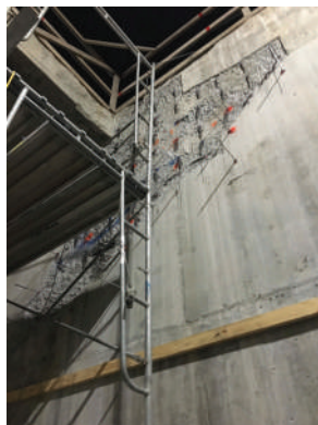
Fig. 7: Reparación de parcheo vertical.
