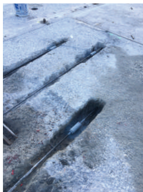
Fig. 8: Hubo que empalmar los cables de postensión con mordazas y reparar el revestimiento dañado.
